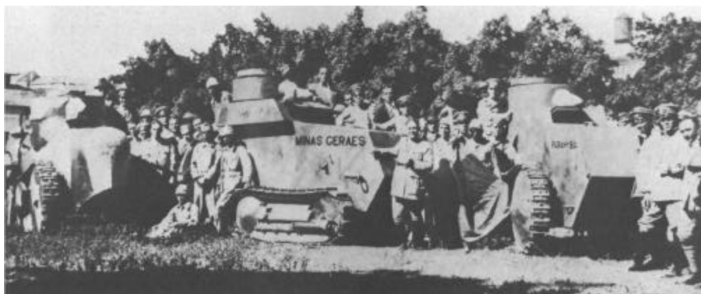
Os três primeiros blindados sobre lagartas desenvolvidos no Brasil na Revolução de 1930, no Rio Grande do Sul, construídos a partir de tratores agrícolas. (Seção de Periódicos, Biblioteca do autor)
