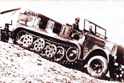
Sd.Kfz. 7 rebocando canhão Krupp 88mm em terreno acidentado
