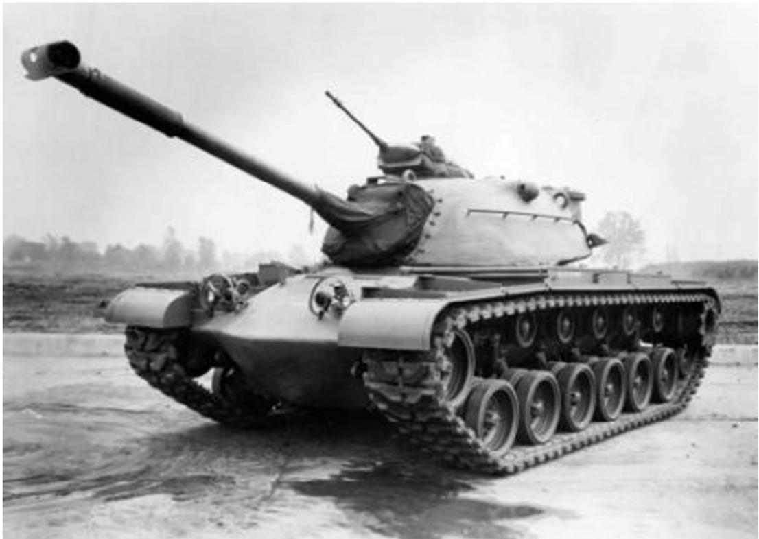
M 48 Patton - canhão de 90 mm, blindagem máxima de 120 mm - motor continental de 750 CV
