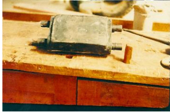
Molde desenvolvido para estudo de recapagem de patim de lagarta do carro de combate leve M-3 com plástico, realizado no PqRMM/2 em novembro de 1966. (Fotos: coleção autor)
