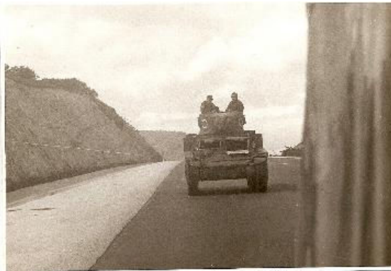
Teste de lagartas Novatração para o M-3 A1 Stuart em 1965/66. (Fotos: coleção autor)
