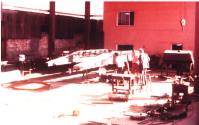
Construção da ponte do XLP-10 na Bernardini em 20.07.76. (Coleção autor)
