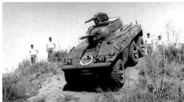
O protótipo CRR realizando testes em 1971. Notar que já estava com a torre derivada do M-8
